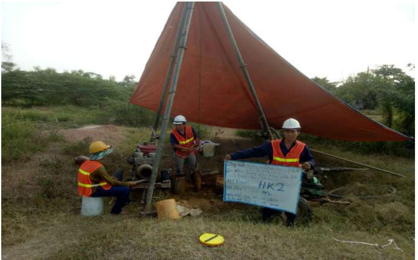
Hình ảnh thi công hố khoan HK2 (1/2)
