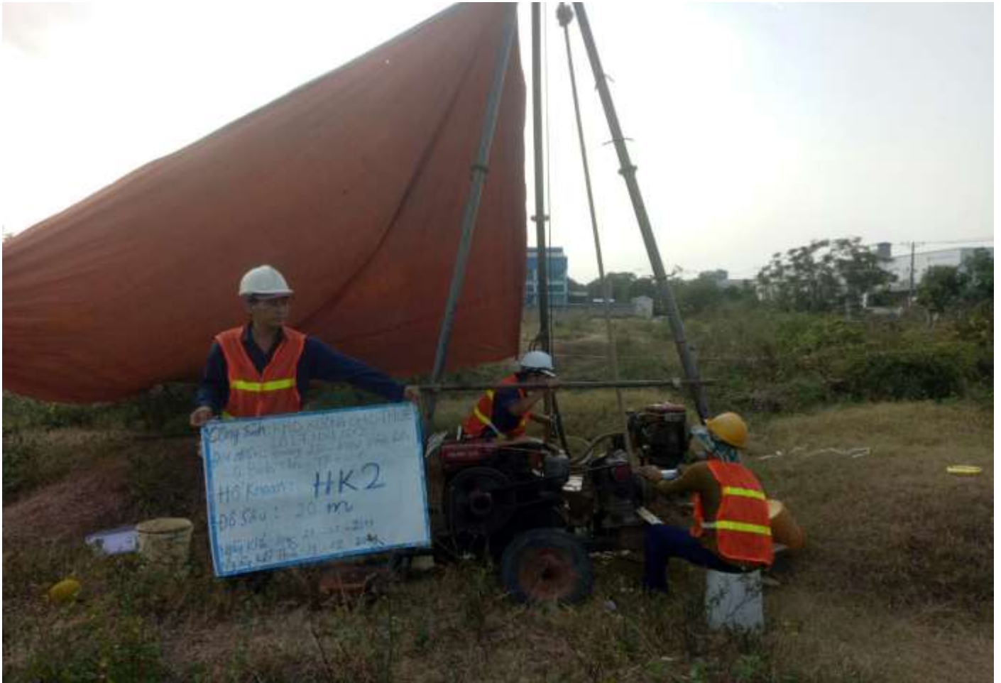
Hình ảnh thi công hố khoan HK1 (1/2)
