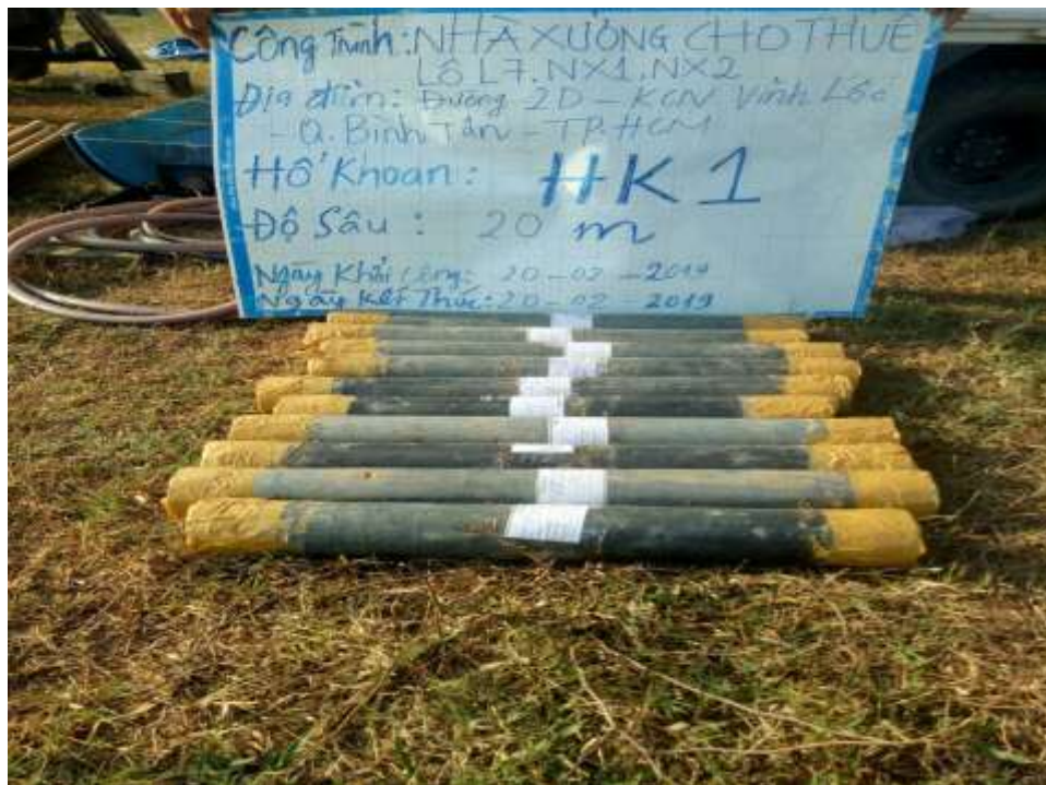
Hình ảnh thi công hố khoan HK1 (2/2)
