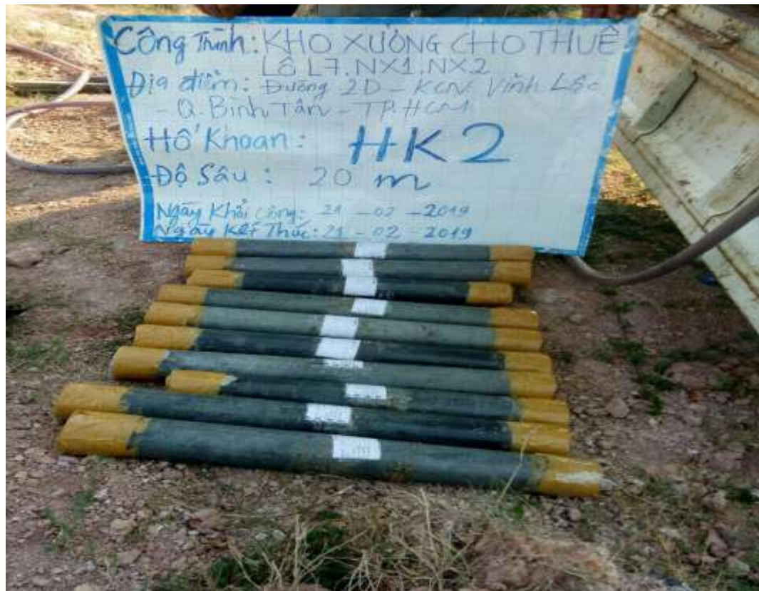
Hình ảnh thi công hố khoan HK2 (2/2)
