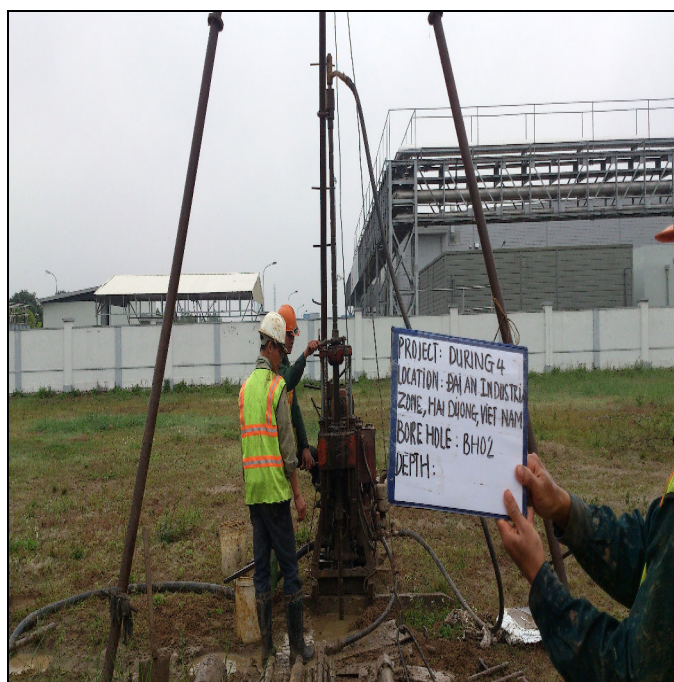
Khoan khảo sát BH-02
