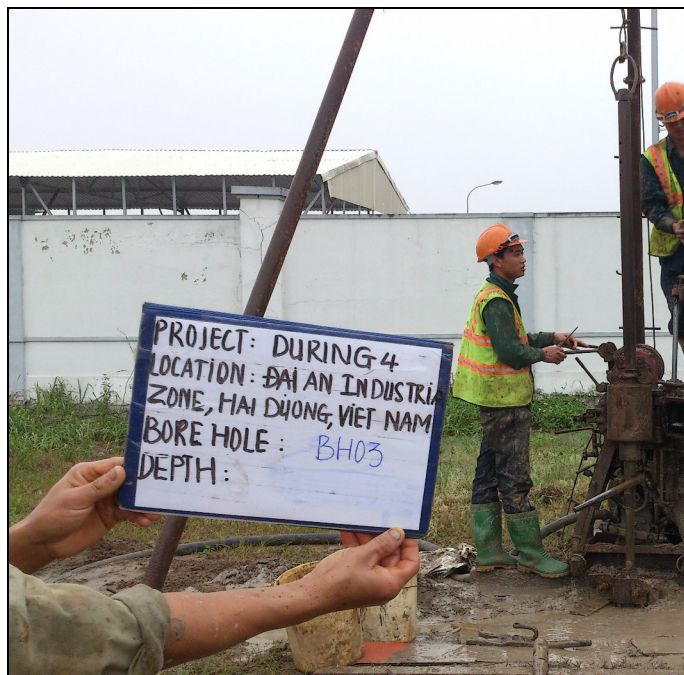
Khoan khảo sát BH-03
