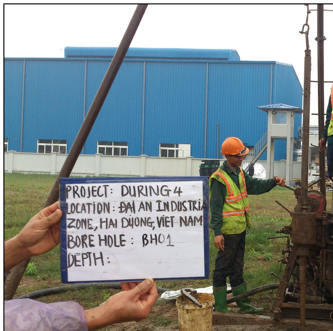
Khoan khảo sát BH-01
