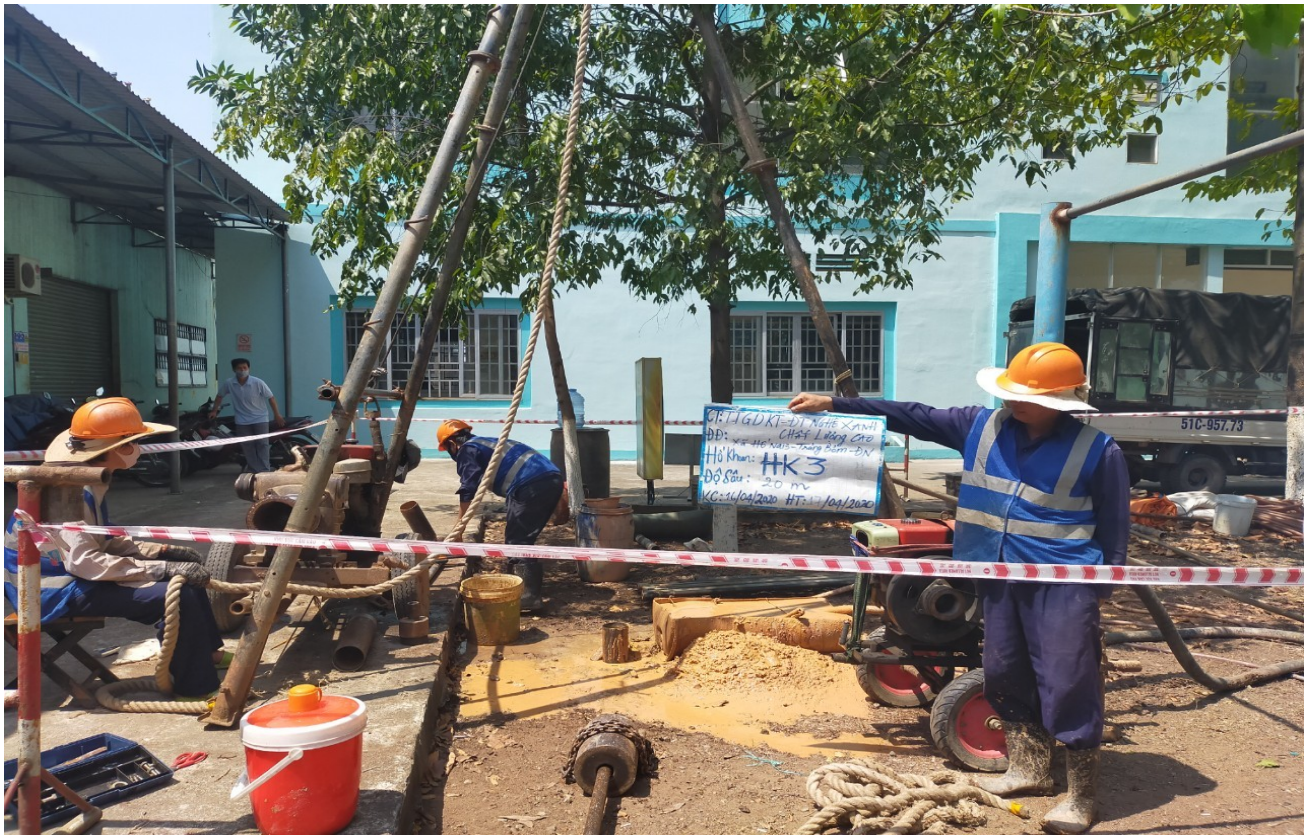
Hình ảnh thi công hố khoan HK3 (1/2)
