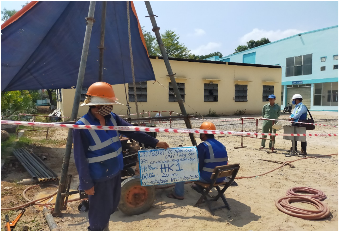
Hình ảnh thi công hố khoan HK1 (1/2)
