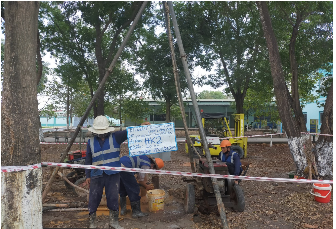
Hình ảnh thi công hố khoan HK2 (1/2)
