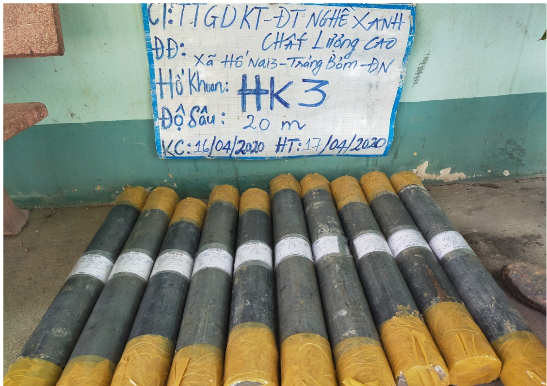
Hình ảnh thi công hố khoan HK3 (2/2)
