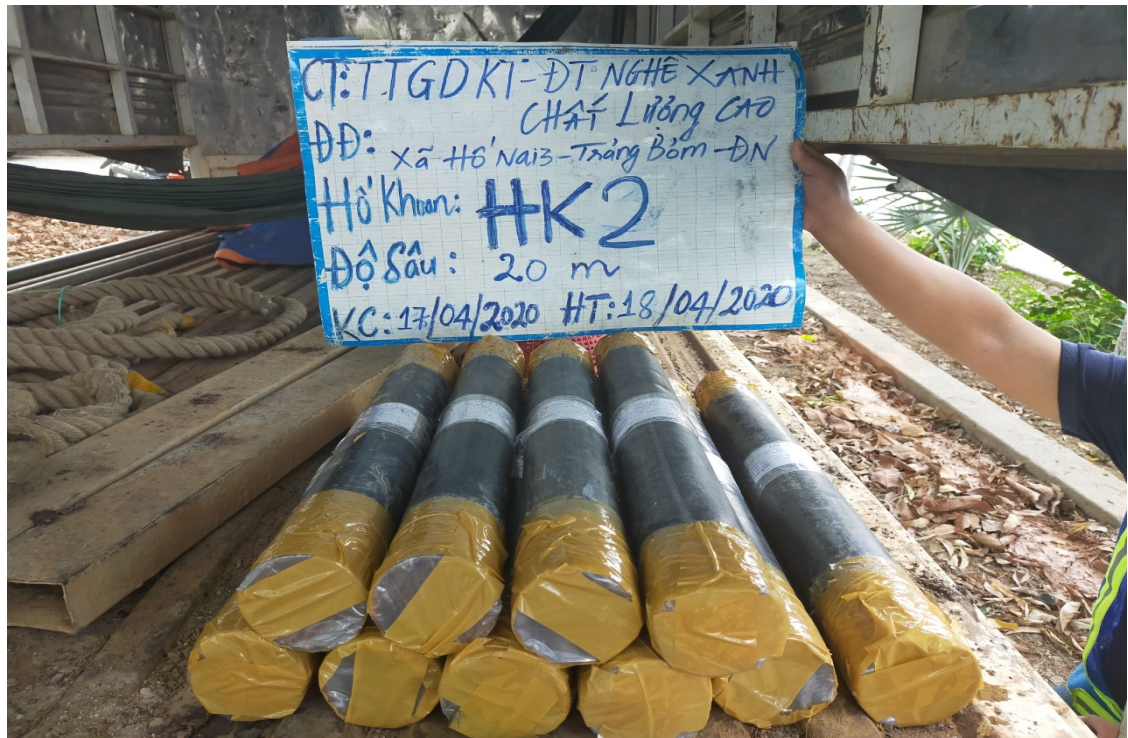
Hình ảnh thi công hố khoan HK2 (2/2)
