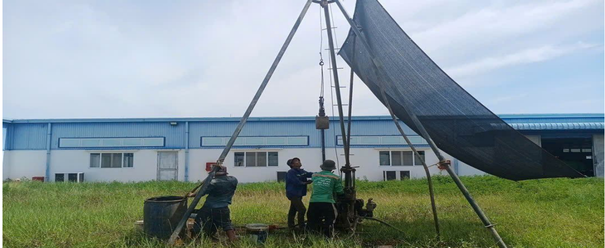
NHÀ XƯỞNG CÔNG TY NICE LINK Lỗ khoan LK02 Độ sâu SPT: 3.50 - 3.95 m
