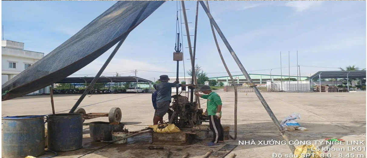
NHÀ XƯỞNG CÔNG TY NICE LINK Lỗ khoan LK01 Độ sâu SPT: 6.0 - 6.45 m
