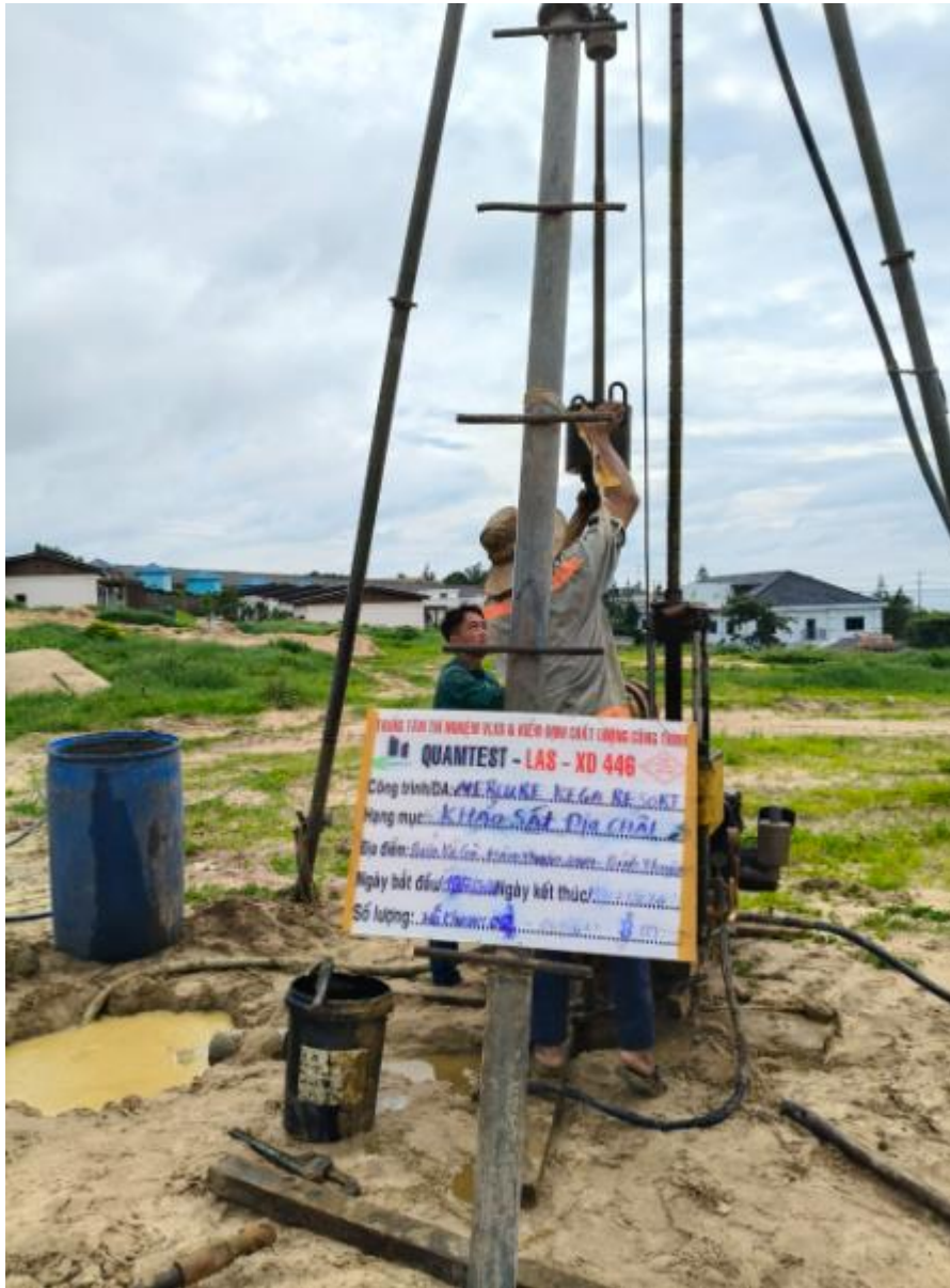
Hình ảnh: Công tác khoan tại hiện trường HK2
