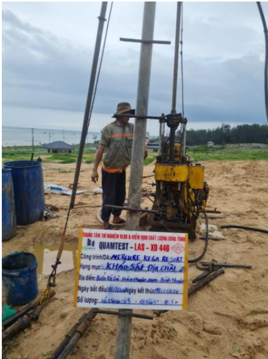
Hình ảnh: Công tác khoan tại hiện trường HK5
