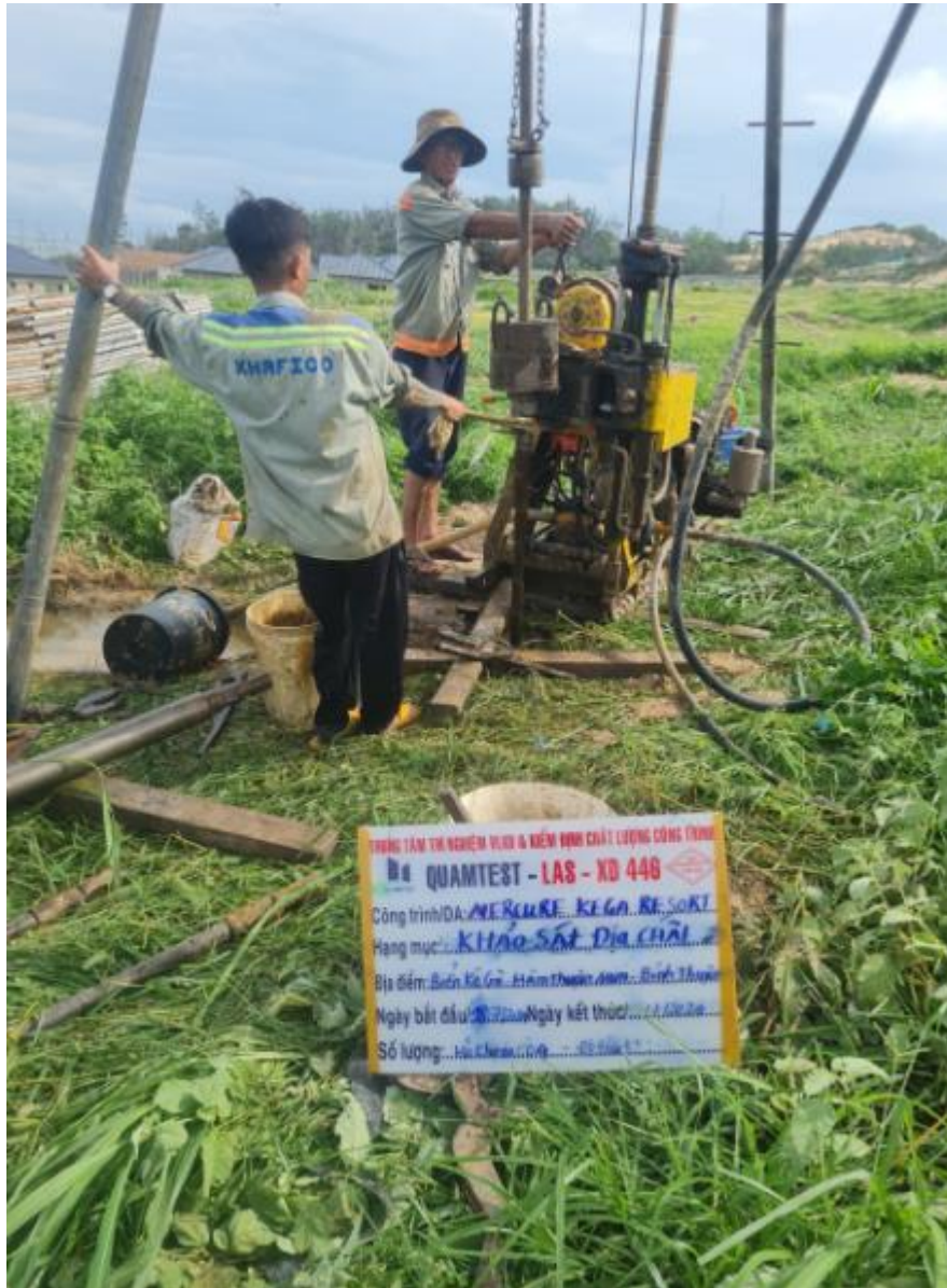
Hình ảnh: Công tác khoan tại hiện trường HK4
