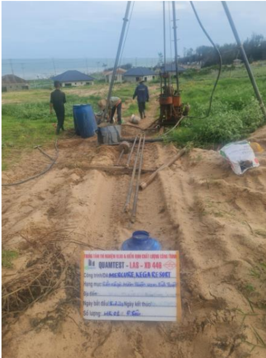
Hình ảnh: Công tác khoan tại hiện trường HK1
