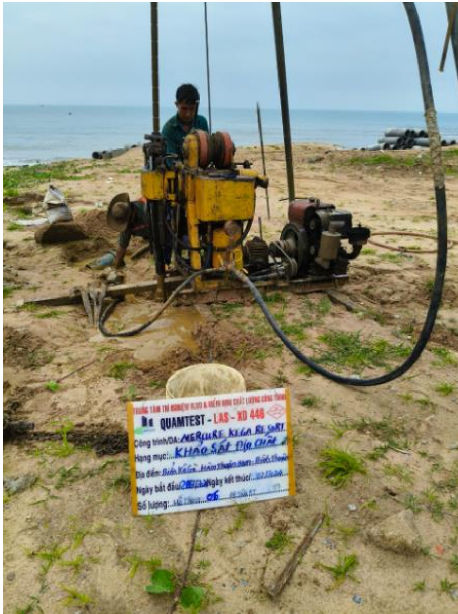
Hình ảnh: Công tác khoan tại hiện trường HK6
