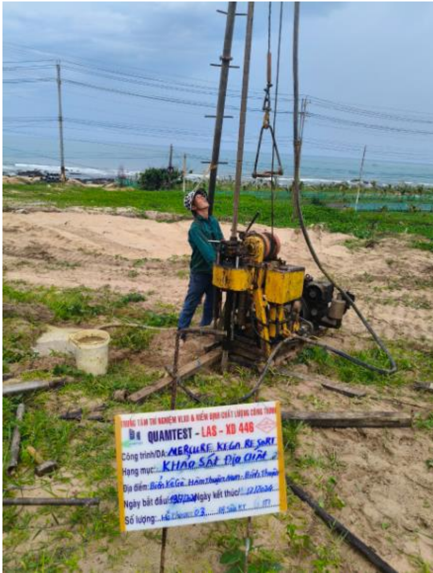
Hình ảnh: Công tác khoan tại hiện trường HK3
