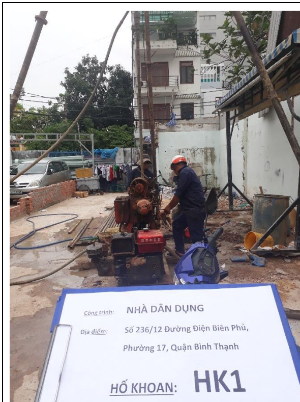
Hình 1: Khoan khảo sát
